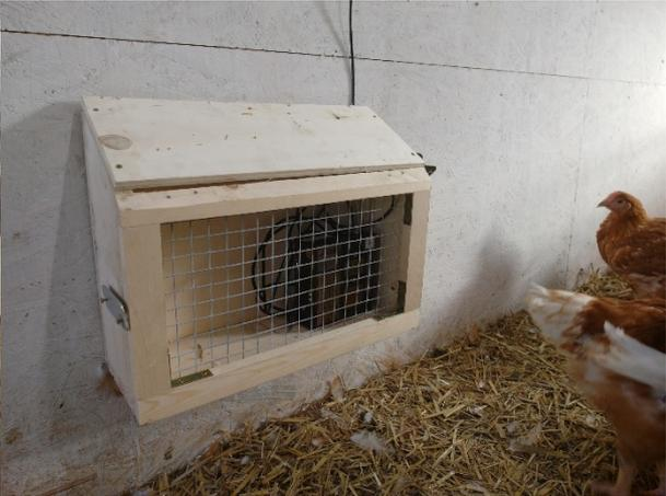
**Abbildung A4** Anbringung eines Schutzkastens für die Pumpe im Stall (Bildautor: Umbach).
